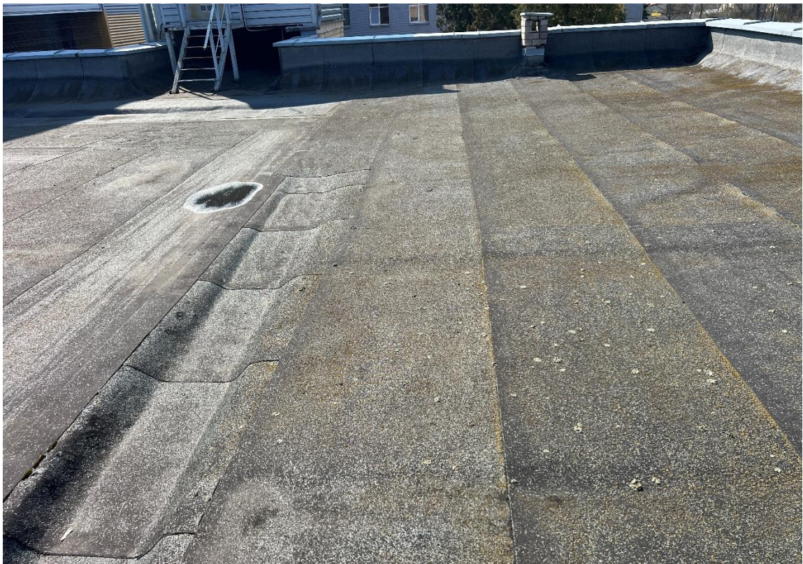
26 pav. Aprašomos pastato dalies stogo dangos būklės fotofiksacija
