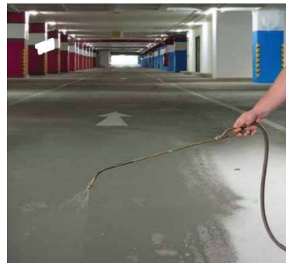
Pav. 7 Impregnanto dengimas aukšto slėgio beoriu purkštuvu
