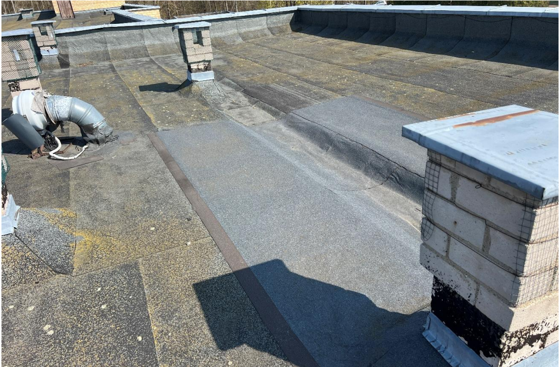
27 pav. Aprašomos pastato dalies stogo dangos būklės fotografacija
