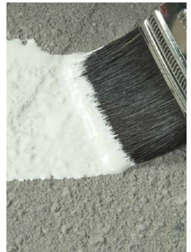
Klijų tepimas ant paruošto betoninio pagrindo
